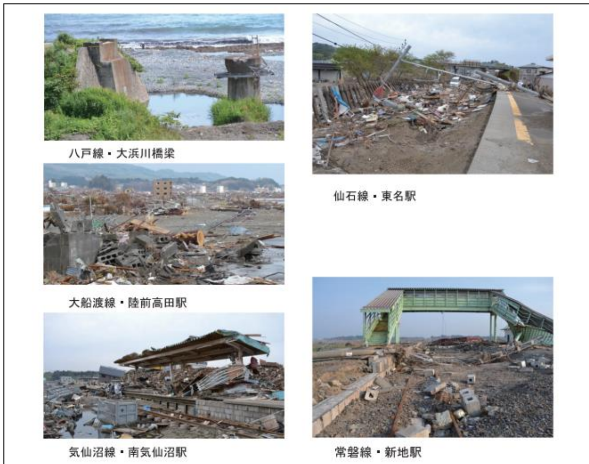
図表 5-8-1 J R東日本被災状況
