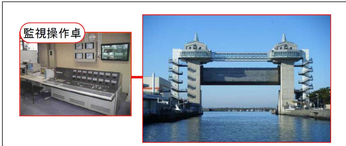
図表 5-6-13 水門の自動化・遠隔操作化イメージ
