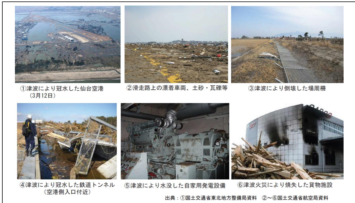
図表 5-7-2 仙台空港の被災状況
