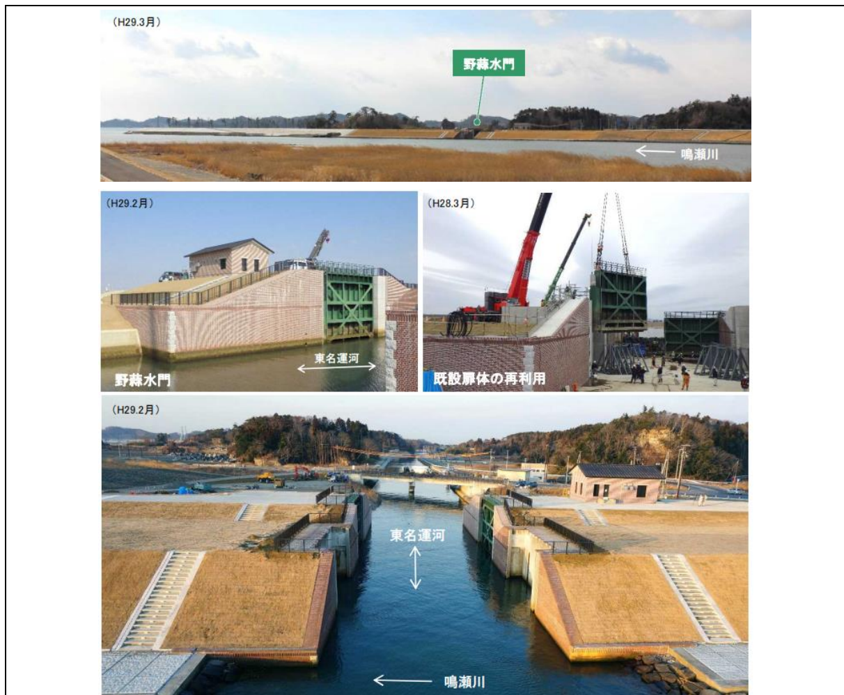
図表 5-6-15 鳴瀬川河口部における整備
